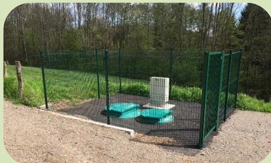
*Le poste de relevage est installé chaque fois que le niveau d'évacuation des eaux usées est situé en contrebas du réseau de collecte ou chaque fois que le niveau du réseau collectif arrive en contrebas du niveau de la station d'épuration.*
