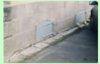
Chaque soupirail est équipé d'un panneau amovible
