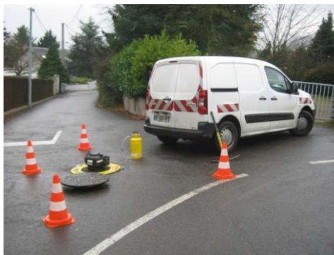
Injection de fumée dans le réseau d'eaux usées
