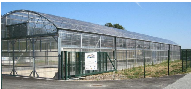
Station d'épuration à boues activées - Anjoutey mise en service juin 2014.
