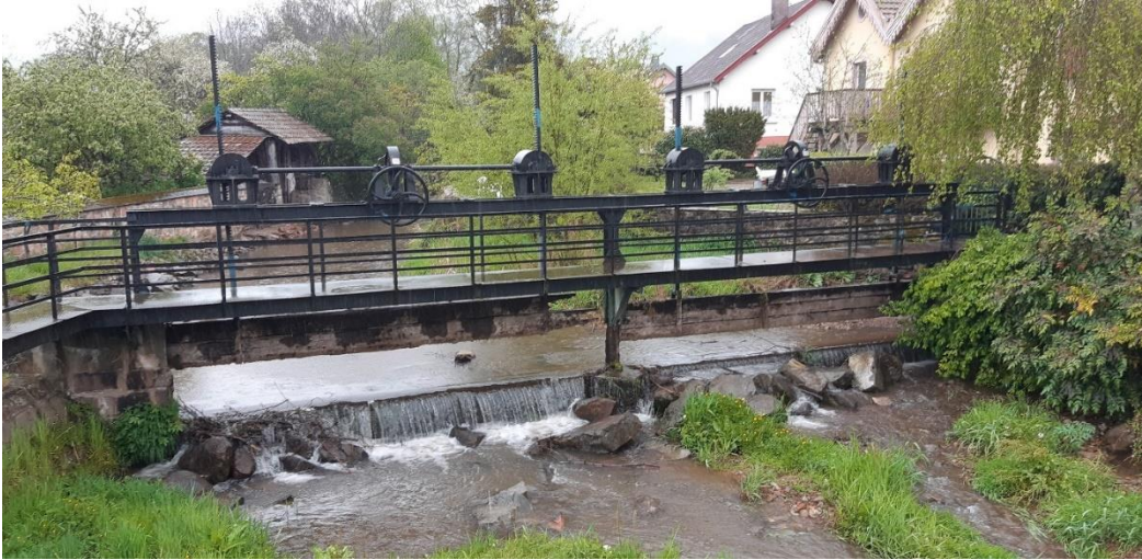
Figure 1 aménagement d'une rampe en enrochement pour la continuité piscicole sur la Rougegoutte
