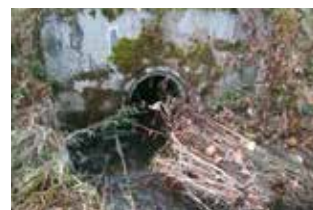
Entrée en amont
