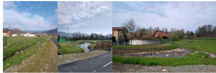
Photos du ruisseau Branden-Hausen après travaux
