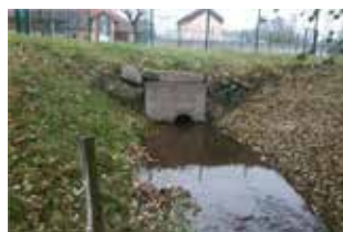
Sortie en aval
